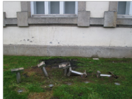
Vista de los destrozos [Fotografía de Ángel Parada]. (Lugo, 2016). Archivo personal.
